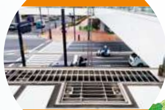
ペDESTリアンデッキ
